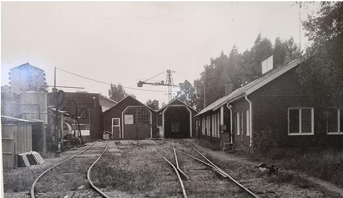
Året är 1983. På bilden ser man de byggnader på södra delen av området som inte finns kvar idag med motorvagnsverkstad, snickeriverkstad och kontor. Foto NJM.
