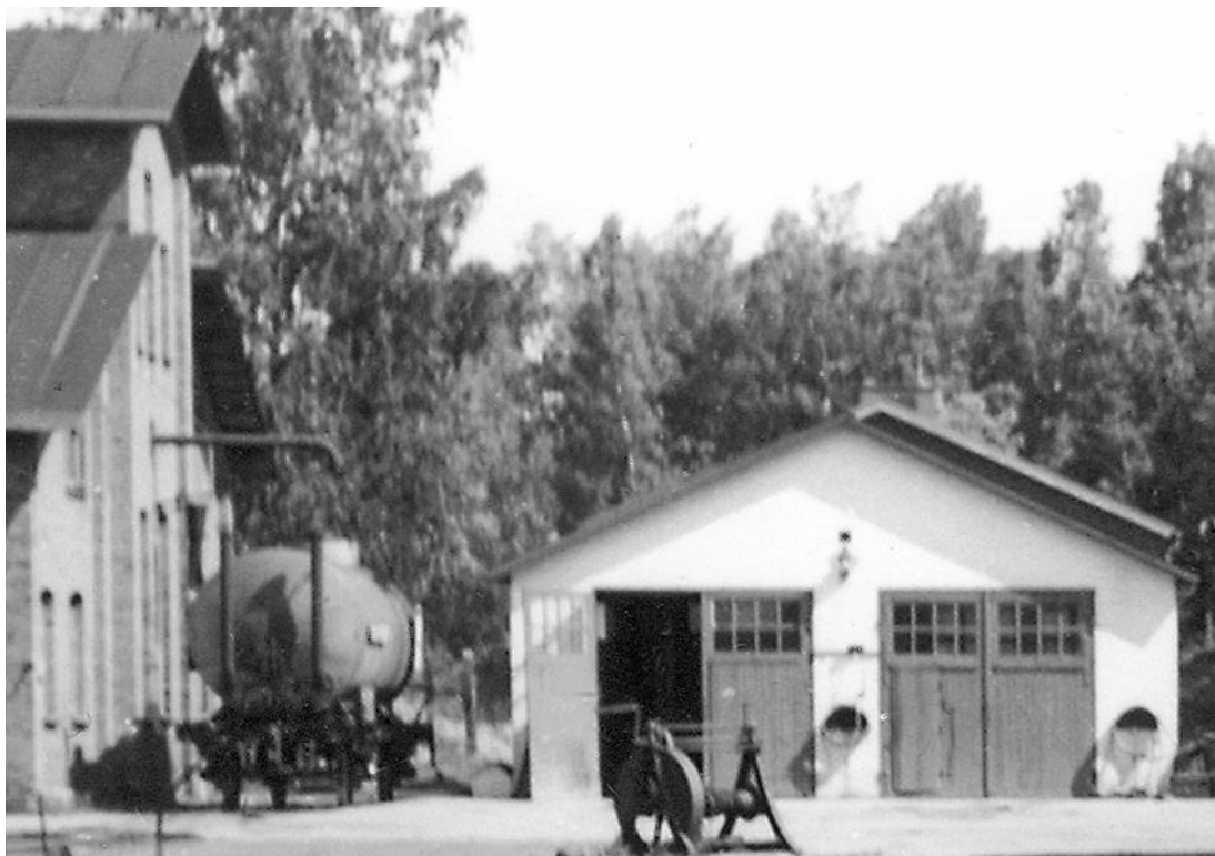
Utsnitt ur föregående bild. Bussgaraget från 1930 ser ut att ha fått sin förlängning vilket den fick 1941 men ännu har inte lackeringsverkstaden tillkommit vilket skedde 1953. Här ser man de ursprungliga träportarna som tyvärr bytts ut mot en stor plåtport där murpelaren i mitten rivits. Lokstallet har fortfarande listtäckt papptak, och ett enklare rör istället för dagens vattenhäst.
