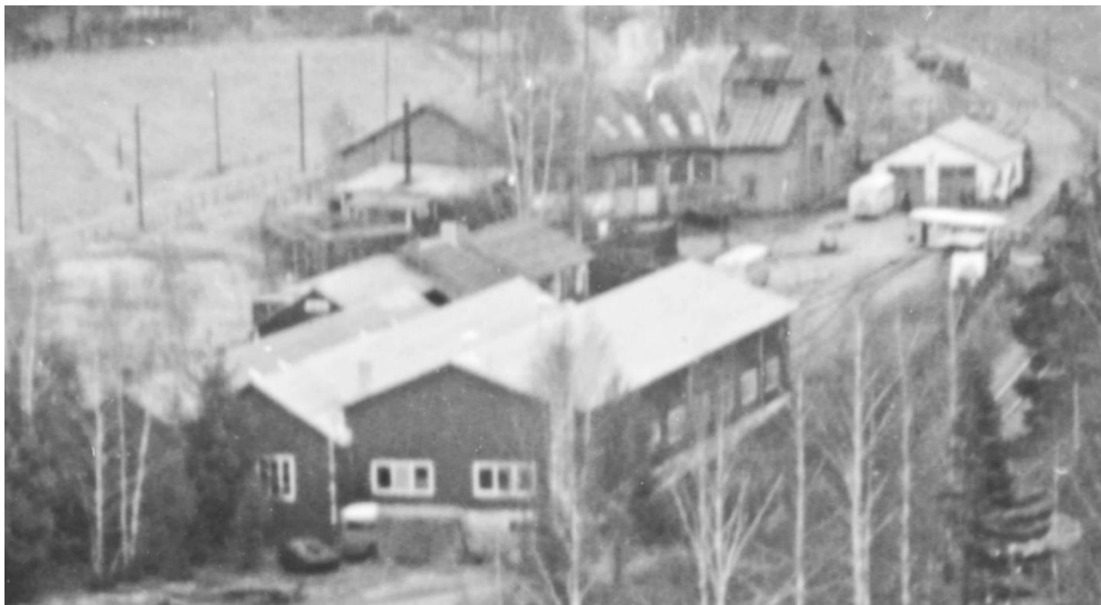
Utsnitt ur föregående bild. I förgrunden ser man de byggnader som ingick i anläggningen och som revs på 1980-talet. Bussgaraget har uppförts men ännu inte byggts på med lackeringsverkstaden så bilden bör vara taken runt 1950. Lokstallarna har fortfarande sina takfönster. Det ryker ur skorstenen till en av kaminerna som stod mellan spår ett och två inne i lokstallet.
