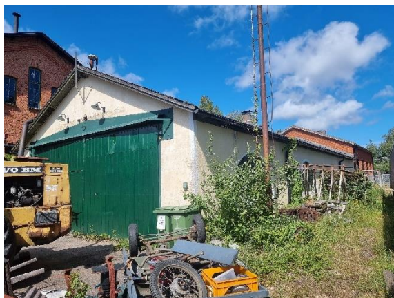
Bussgaraget's södra gavel och östra långsida.
