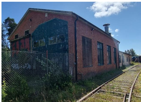
Lackeringsverkstadens norra gavel med västra långsidan till höger.
