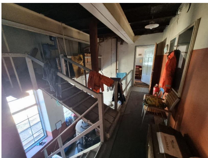
Övervåningens spång med trappan upp till vattentornet.
