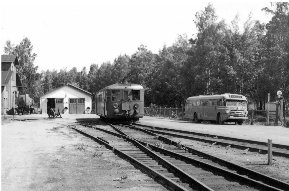
Bussgaraget rakt fram och lokstallarna till vänster. Bussen till Tungelsta står inne. Framför bussen står sannolikt den Ljungmanpump som nu står bevarad inne i bussgaraget. Foto Bengt Hammar, Nynäshamns kommun.
